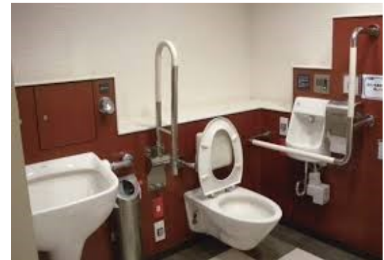
(障害者用トイレ)
