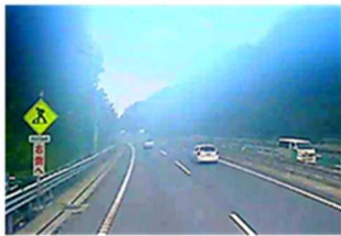
① 工事中 2000m先 右側へ
