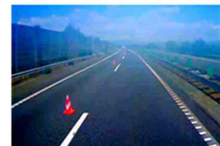
⑥ 第1通行帯規制区間 (ロードコーン設置)
