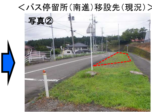
バスベイを設置し、停留所を移設
